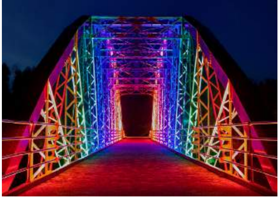
Puente de los Remedios, Villafranca de Cordoba 2022
