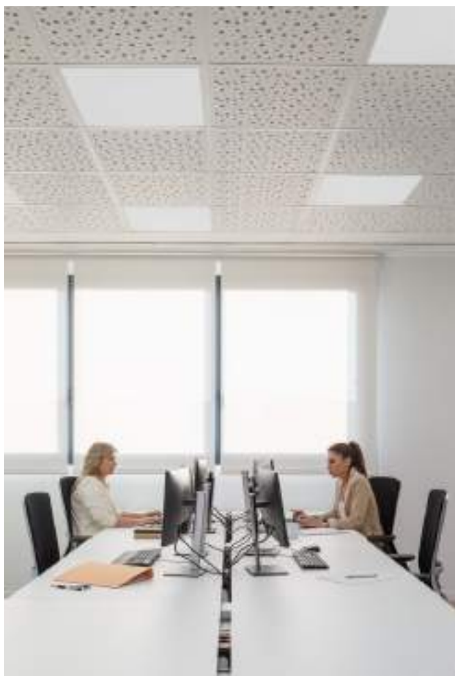
Iberspa, 2022. Casambi lighting control. Daytime slot. Contrôle de l'éclairage Casambi. Plage horaire de jour.
